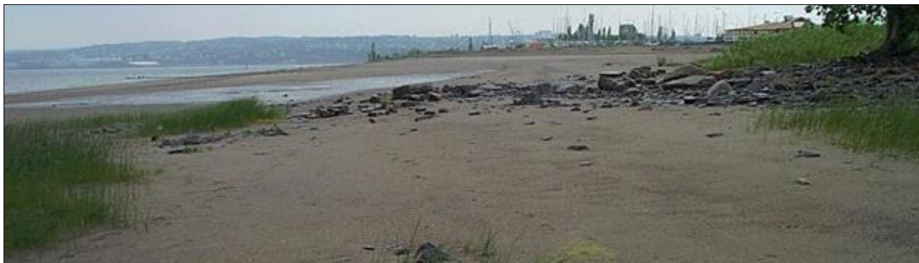
Figure A10: Épi stabilisant partiellement l'extrémité nord de la plage des battures (juillet 2003)
