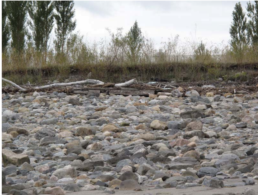
c) Érosion du talus en haut de plage dans la zone sud de la plage
