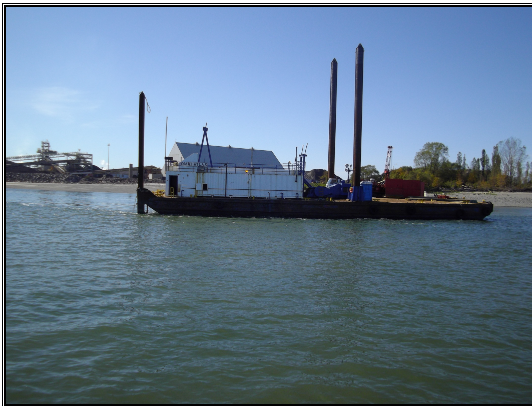
Photographie no E1 : Vue de la barge OMNI Atlas.
