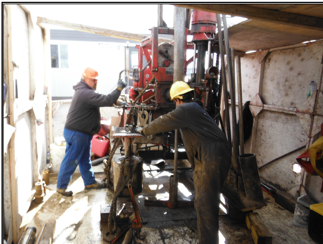
Photographie no E4 : Vue de la foreuse BBS-15 (barge OC/45).
