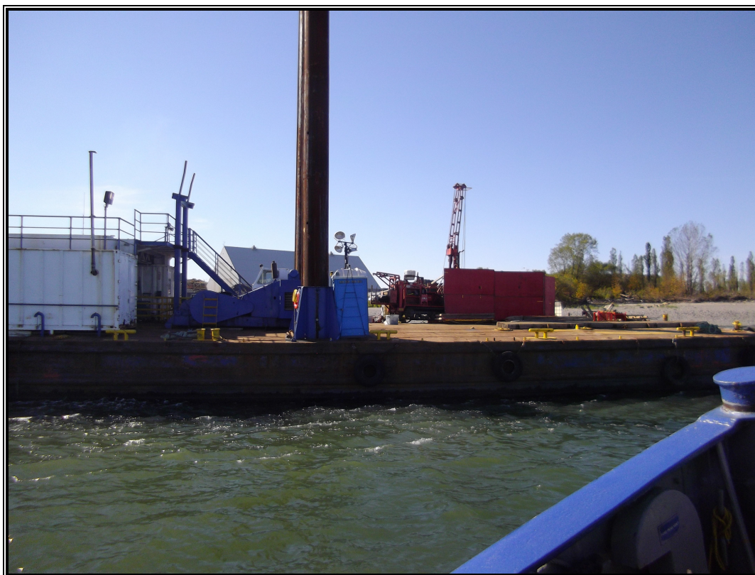
Photographie no E2 : Vue de la barge OMNI Atlas.
