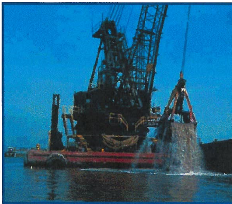
Figure F2 Grue à benne preneuse sur barge
