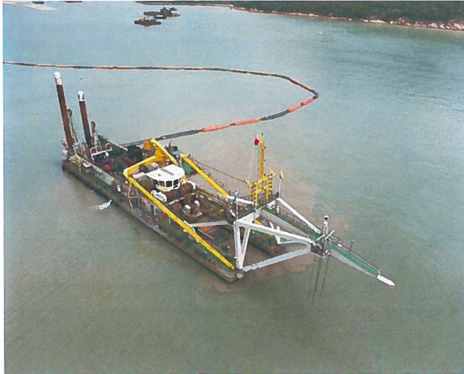
Figure F7 Dragage hydraulique à tête désagrégatrice en action avec ses tuyaux de pompage des sédiments dragués vers le site de dépôt
