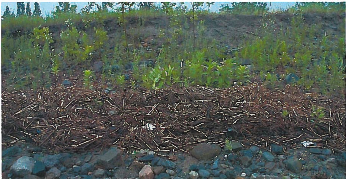
Figure G3 Traces d'un talus d'érosion de niveaux d'eau hauts exceptionnels
