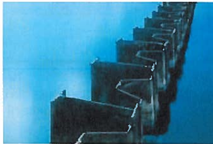
Figure 3.3 Mur en pieux-palplanches
