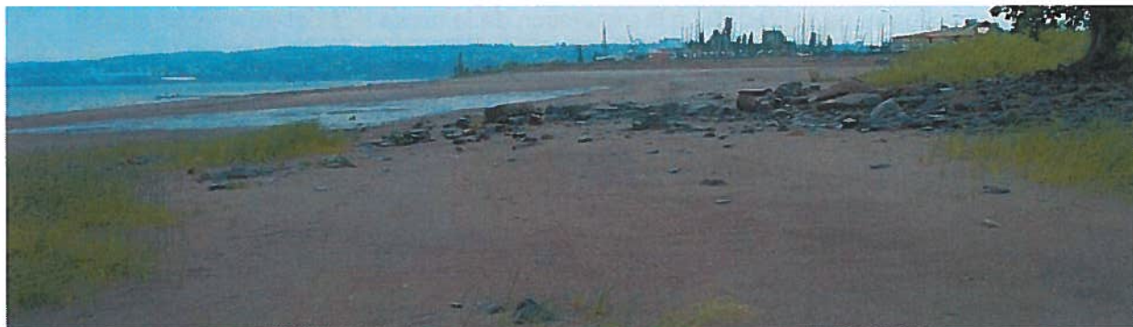
Figure G6 Épi stabilisant partiellement l'extrémité nord de la plage des battures
