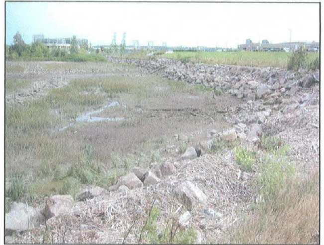
Photo 7. Enrochement, rive ouest du rentrant sud-ouest
