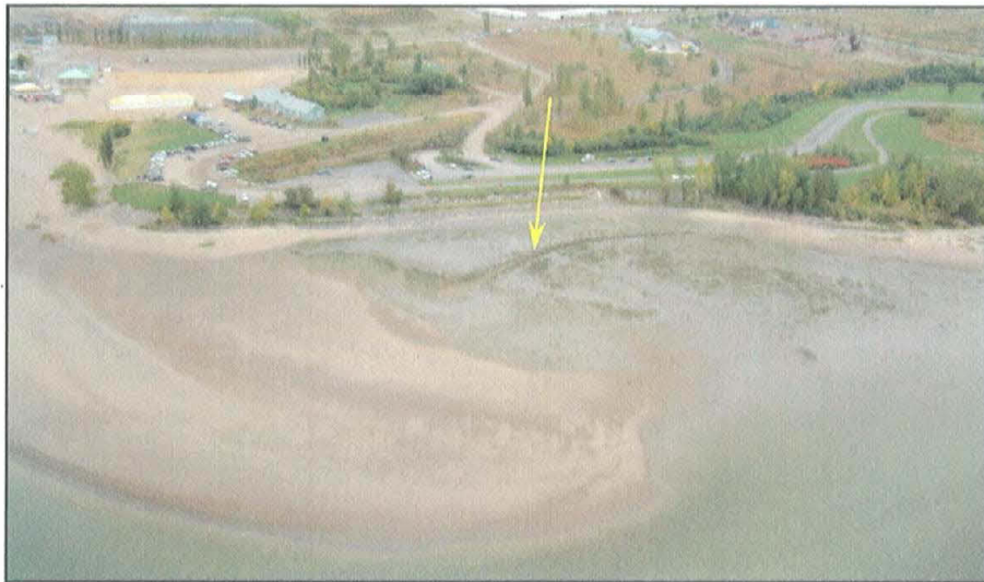
Photo 13. Vue partielle du rentrant sud-ouest, montrant une digue aménagée
