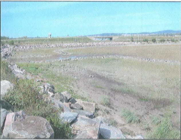
Photo 8. Digues érigées au fond du rentrant sud-ouest
