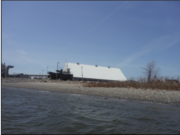
Photo 34 (F0572 du CD) Rive enrochée et ensablée située au nord du quai 53
