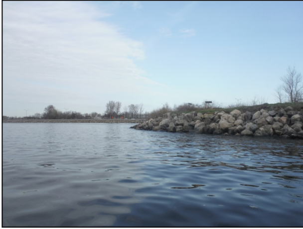
Photo 14 (F0526 du CD) Rive enrochée Rive ouest de la Baie de Beauport
