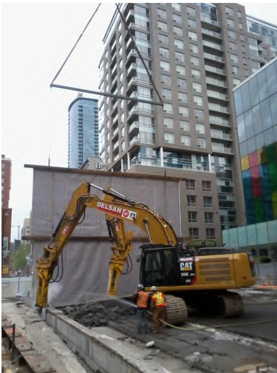
Figure 8-1 Exemple d'utilisation de toiles acoustiques suspendues par une grue
