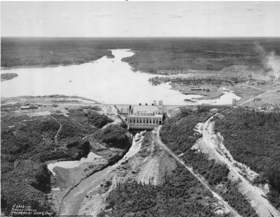
FIGURE 2.1-1 PHOTOGRAPHIE HISTORIQUE DE LA CENTRALE DE SMOKY FALLS
