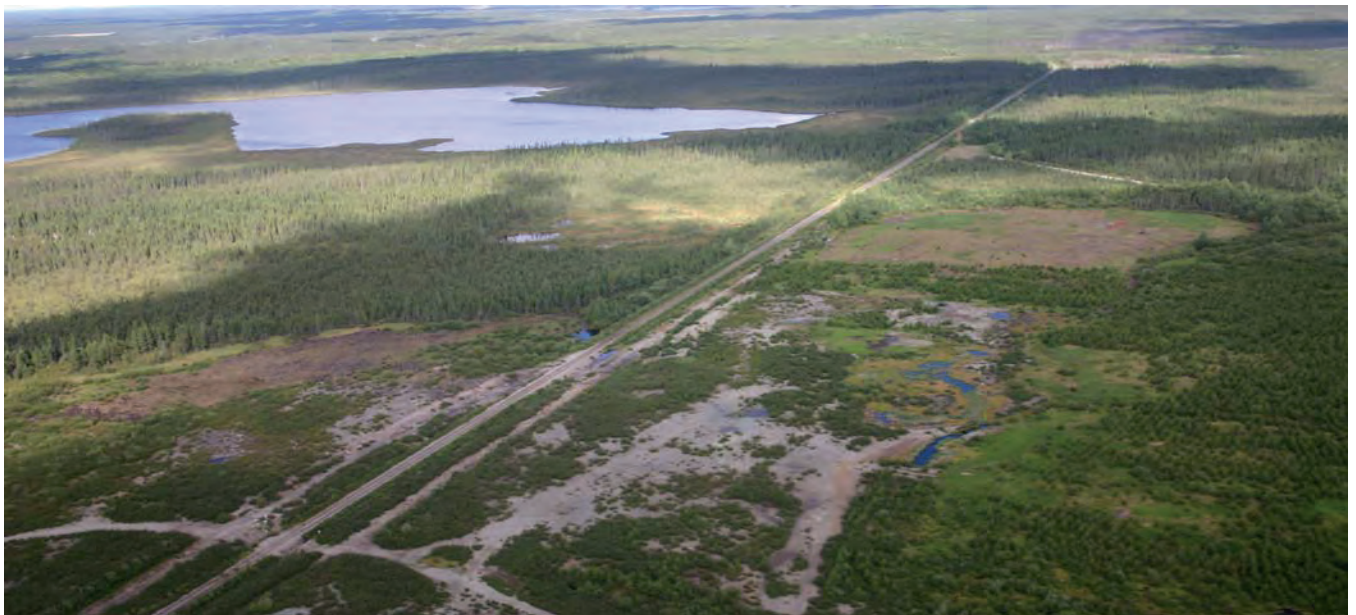
Photo 3 Vue aérienne oblique vers l'ouest du poste de transbordement de l'ancienne scierie Gagnon Frères. On aperçoit la voie ferrée existante du CN qui traverse le centre de la photo et les anciennes voies d'évitement aujourd'hui démantelées. En arrière plan, on voit le lac Pierre.
