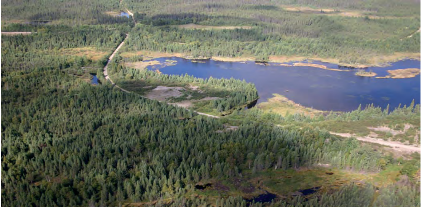
Photo 11A Chemin du lac Denis (tronçon 3) débutant au sud (à gauche sur la photo) du lac Yvette (la portion nord du chemin du lac France se connecte au sud du lac Yvette). Sur la photo, l'option du lac Bernadette (tronçon 3, option 2) passe au-dessus du lac Yvette (côté ouest) dont on aperçoit une partie du tracé.
