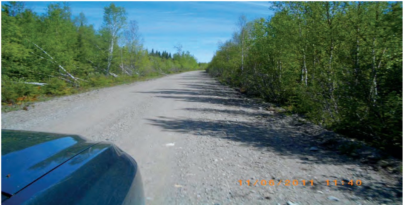
Photo 9A Chemin Lemoine (tronçon 2 : option 1 du chemin de la mine Lemoine) à quelques centaines de mètres de l'intersection avec le chemin 210. Le camp des travailleurs (option 1 : le camp du chemin Lemoine, option rejetée) se trouve du côté gauche de la route.
