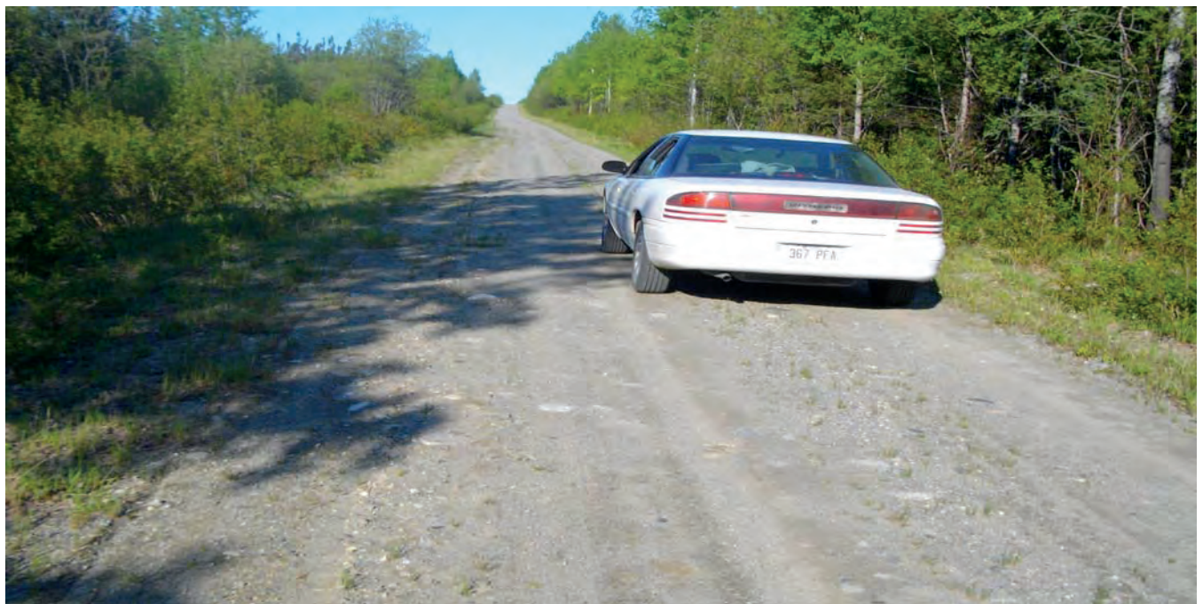
Photo 10A Chemin forestier n° 210 entre l'intersection du chemin Lemoine au km 19 et le début du chemin du lac France au km 21,9 (tronçon 2, option 2); le chemin doit être élargi mais est en bon état et ne requière aucune réfection majeure). L'option du chemin du lac France débute au bout de la route, du côté droit (nord), tandis que le camp des travailleurs (option 2 : le camp du chemin 210, option retenue) se situe du côté gauche (sud).
