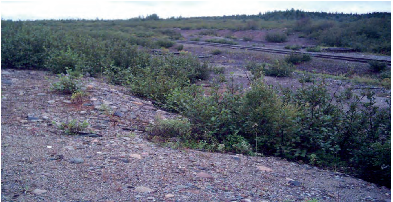
Photo 4 Vue au sol du poste de transbordement; la voie d'évitement suivra la voie ferrée principale en place et les terrains qui lui sont contigus serviront à l'entreposage du concentré.
