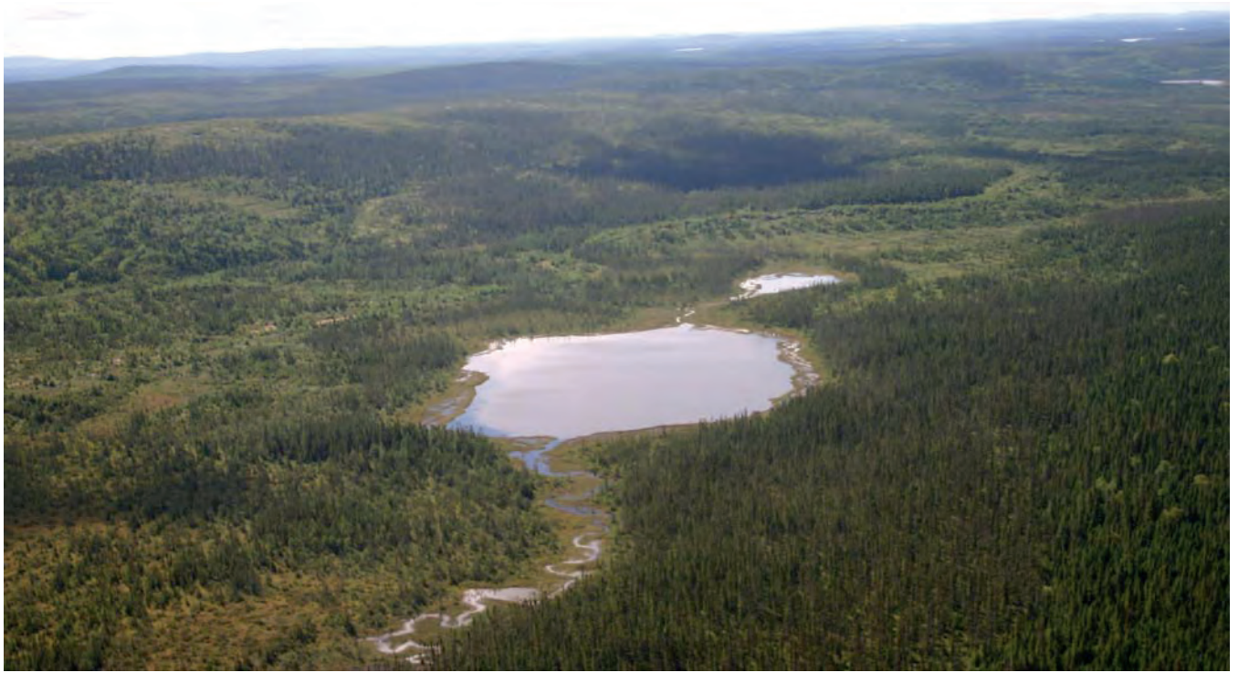
Photo 7 Halde à stériles : autre point de vue vers le sud de l'emplacement de la halde et du parc à résidus grossiers qui occupent le terrain à l'arrière des lacs Coil et B-5 (partie supérieure droit de la photo).
