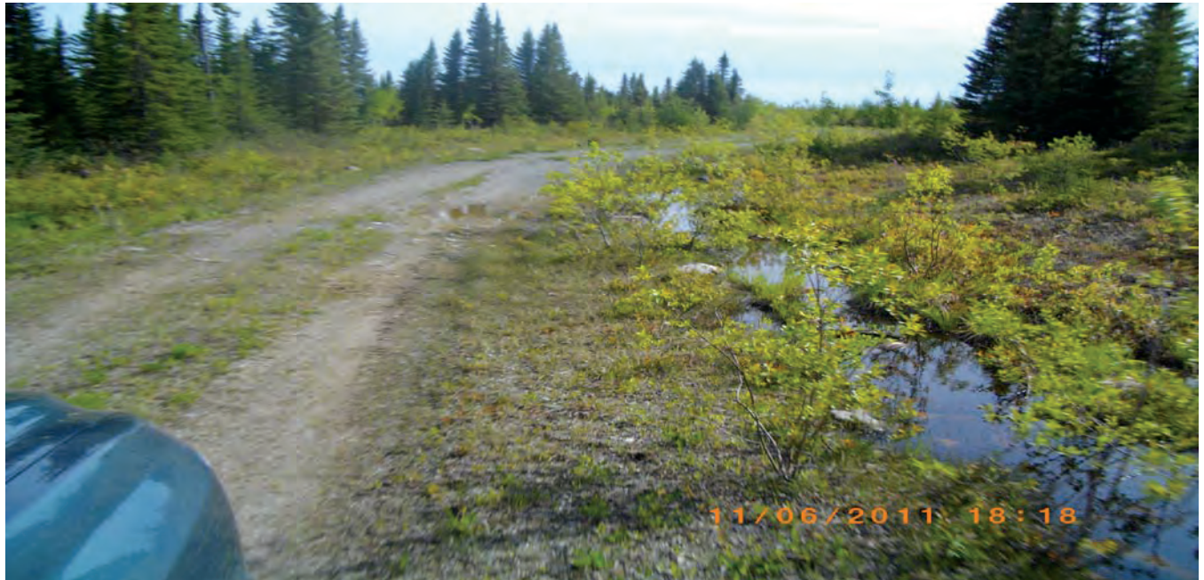
Photo 9B Chemin Lemoine (tronçon 2 : option 1 du chemin de la mine Lemoine) à 2,8 km de l'intersection du chemin 210; rehaussement de la route, élargissement et amélioration du drainage..
